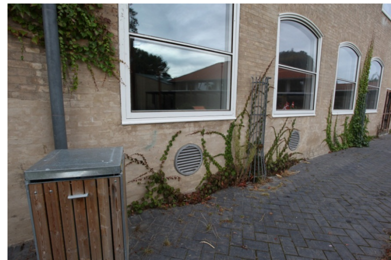
Figur 19 Indtag med varmemflade i facade, NaVent model. Kilde: Airmaster.dk
