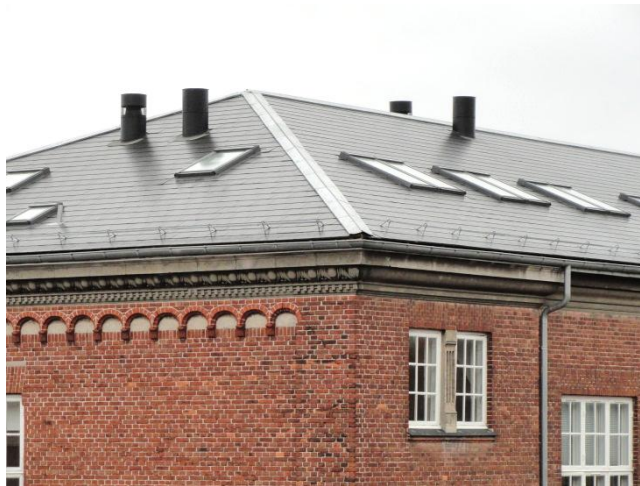
Figur 28 Eksteriør. Synlig, inddækket ventilationsinstallation, Roskilde Universitets Center.
