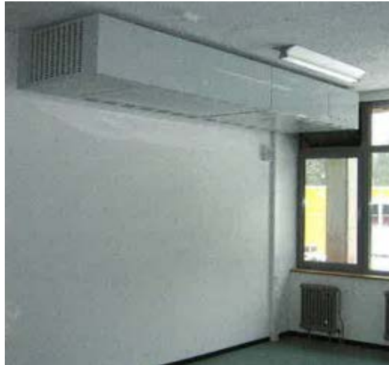
Figur 55 Synlige, temmelig pladsklemte, ventilationskanaler under loft i folkeskole.
