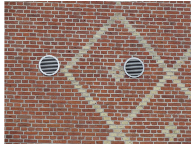
Figur 28 Eksteriør. Synlig, inddækket ventilationsinstallation, Roskilde Universitets Center.
