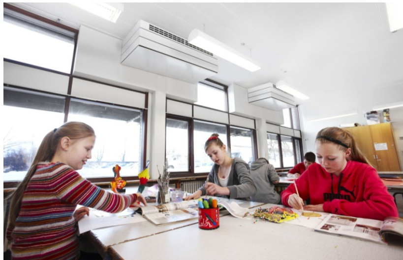
Figur 14 Skolefløje med centralt balanceret ventilation med kanalerne ført på taget.
