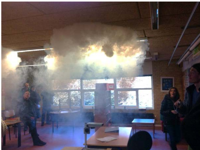
Figur 54 Klemte ventilationskanaler bag akustikloft i klasselokale.
