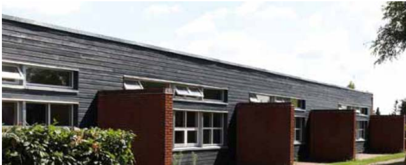
Figur 20 Gennemføringer til varmekilder i facaden.
