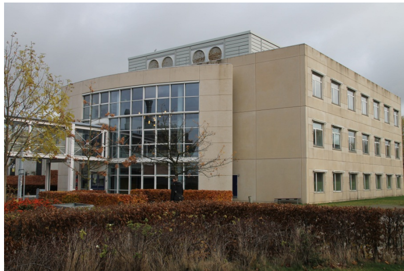
Figur 27 Eksteriør. Synlig, uinddækket ventilationsinstallation, Roskilde Universitets Center.
