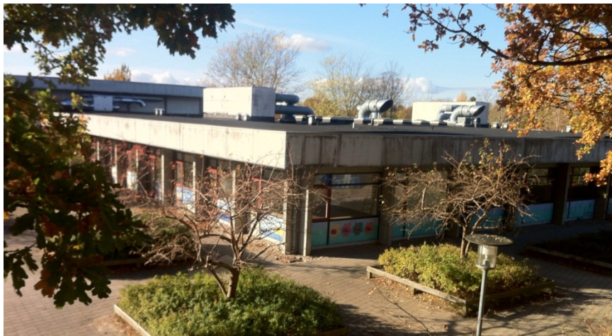
Figur 11 Synlige, ikke-integrerede ventilationsaggregater og -kanaler på taget af skole fra 1970'erne.
